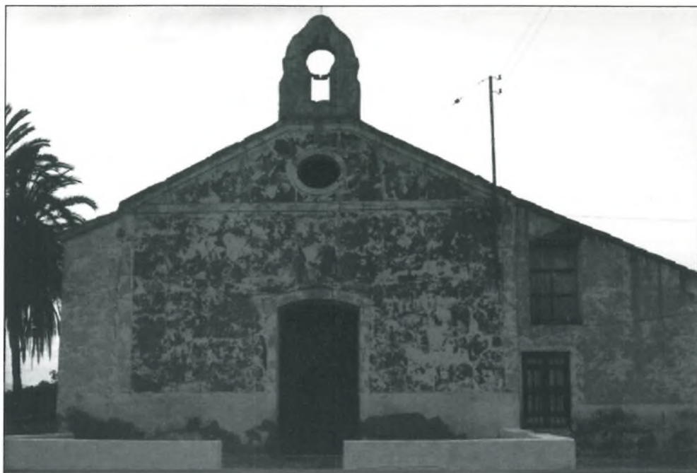
Ermita. La voz negra, fachada. Alcantarilla.
