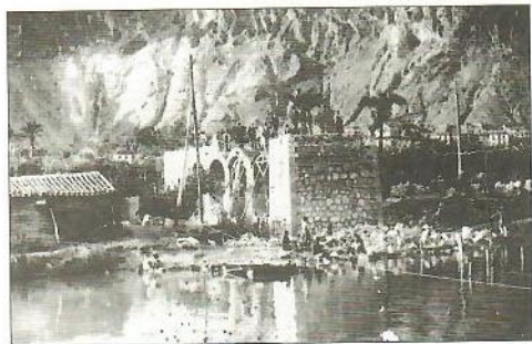
Construcción del puente sobre el río Segura. Entre Villanueva-Ulea. 1925.
