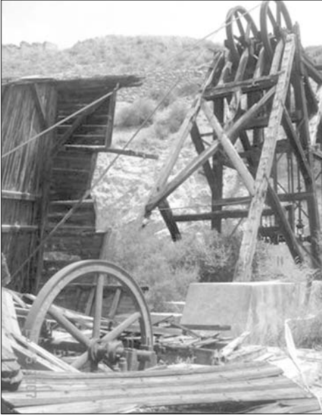
Mina impensada. Uno de los pozos de infinita tragedia accidental de las minas de Mazarrón, extensamente tratado por infinidad de periodistas y autores; y, del mayor rigor investigador por el propio Guillén Riquelme.
