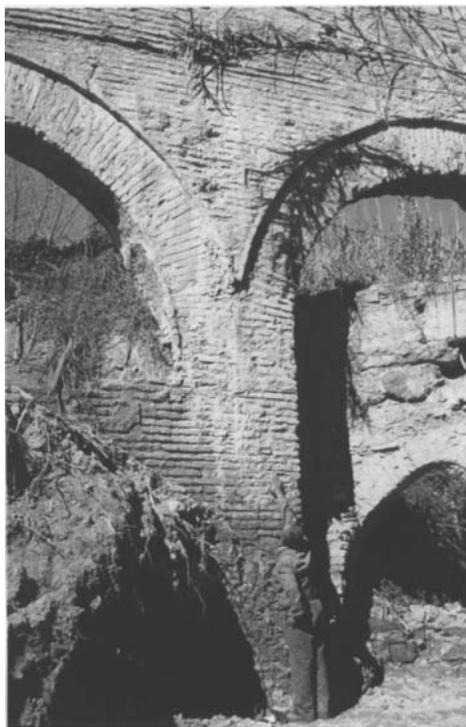
Grandiosidad del pilar excavado en el Acueducto de la Rueda constituido por 26 arcos de medio punto y más de 170 metros de longitud. Imagen de la altura en el margen derecho de la acequia "Turbedal".
