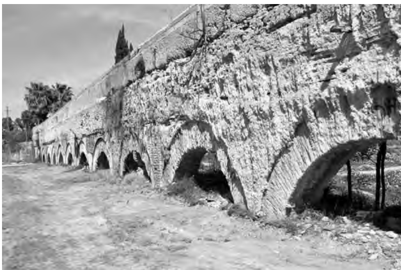
Aspecto que presentaba el acueducto al comenzar los trabajos arqueológicos.
