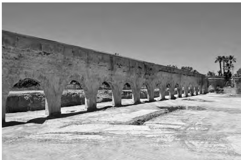
Vista del acueducto tras la eliminación de los sedimentos que lo envolvían y con los arcos ya abiertos.
