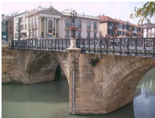
Figura 6. Puente Viejo o de Los Peligros y Templete en el corazón de la ciudad de Murcia que reúne la doble función de comunicación y protección mariana. Fotografía: G. Canales.
