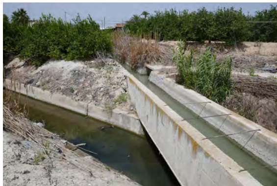
Figura 5. Espectacular encabalgamiento de la acequia Nueva del Raal sobre el Merancho del Gil. Canalización que sirvió para colonizar el marjal de La Urdienca-El Raal en el siglo XVIII. Fotografía: G. Canales.
