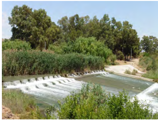
Figura 1. Azud de la Contraparada, origen de la Huerta de Murcia y el elemento fundamental del edificio hidráulico, ya que de él deriva la red de riego. Fotografía: G. Canales.
