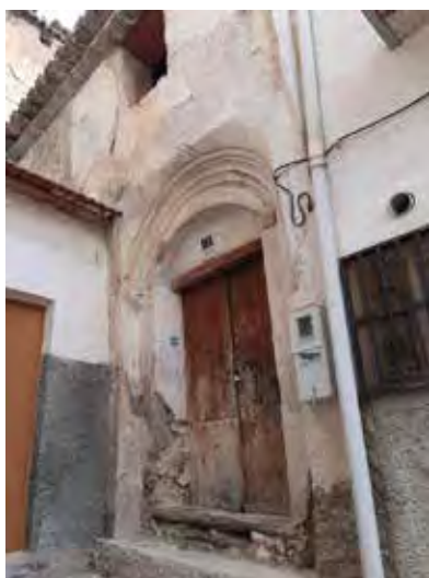
Figura 3. Fachada de la casa.
