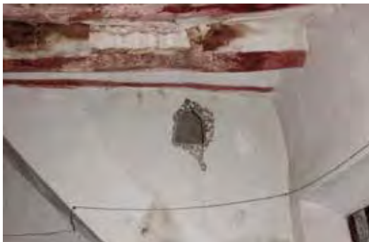
Figura 7. Detalle de la escalera de subida al primer piso.
