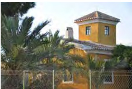
Figura 9. Similar a la Casa Amarilla antes citada, la imita desde la modestia, como muchas otras construcciones del paisaje de los huertos. Fuente: Elaboración propia.
