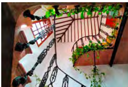
Figura 28. La escalera y carpinterías del Huerto de la Bola demuestran las posibilidades que ofrece la rehabilitación de este tipo de edificaciones. Fuente: Elaboración propia.
