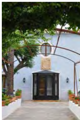
Figura 20. Huerto Peñalver. También llamado La casa Azul, enfrenta su fachada simétrica al portón de entrada a la finca. Fuente: Elaboración propia.
