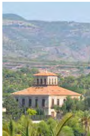
Figura 19. Huerto San Ignacio. Su contundente volumen es tan visible como su deterioro actual. Fuente: Elaboración propia.
