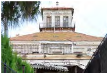
Figura 26. Decadencia y falta de mantenimiento, es lo que se encuentra en el Huerto San Ignacio. Fuente: Elaboración propia.
