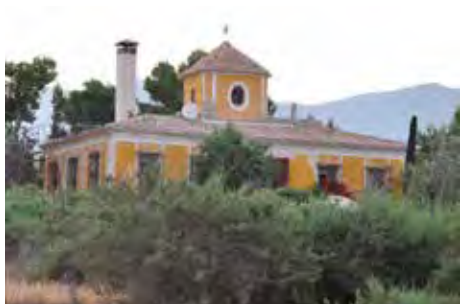
Figura 5. Huerto Casa amarilla. Comparte con el huerto siguiente la simetría, huecos ovalados, molduras en blanco y revocos en tonos fuertes. Solo su torre busca protagonismo. Fuente: Elaboración propia.
