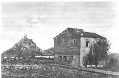
Figura 6. Pintura de la torre de Los Mellizos antes de reformarla.
