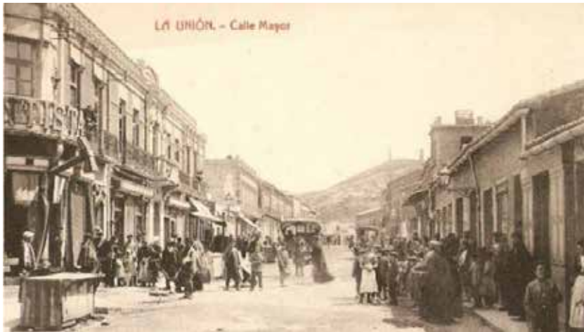
Figura 1. Calle Mayor de la Unión s. XIX. Fuente: https://losalcazares.destinosdesol.es/es/turismo-desde-residencial-la-union-cuarto-siglo-recordando-ultimos-mineros/
