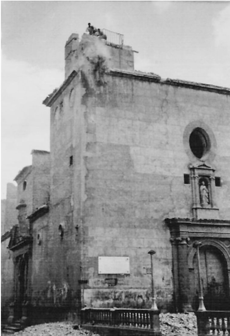
Figura 4. Derribo del campanario de la iglesia de San Pedro, 1961. Se aprecian con claridad la considerable altura que alcanzaba el edificio y la sucesión de los altos estribos que definían las capillas hornacina. Fuente: Colección María José Gómez Guillén. Archivo Municipal de Alcantarilla.
