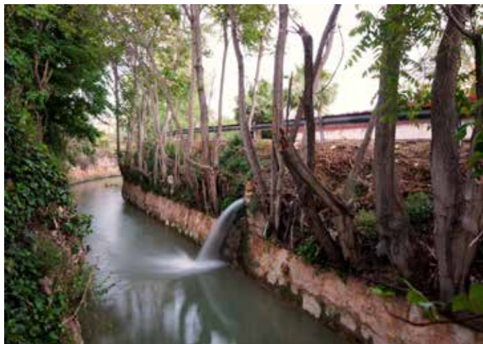
Figura 7. Desembocadura acequia menor daba sobre acequia mayor de Barreras en Nonduermas. Fuente: Mateo Rubio.
