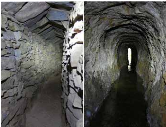
Figura 2. Últimos metros reforzados de la Mina I y excavación desnuda de la Mina III. Fuente propia.
