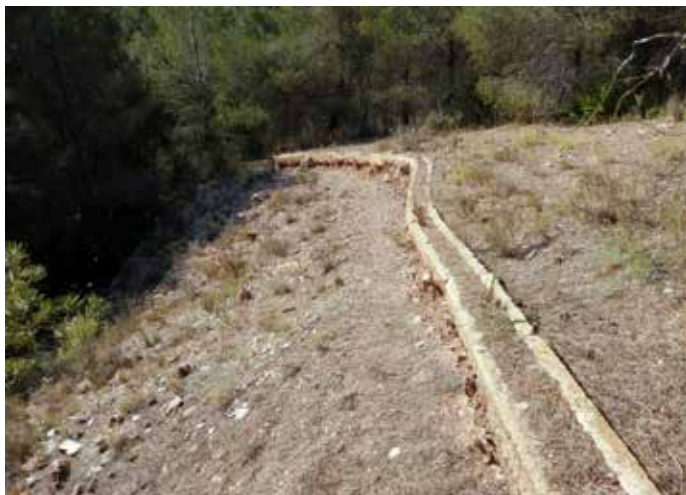
Figura 4. Acequia de secciones de caño de arenisca, conducción principal. Fuente propia.
