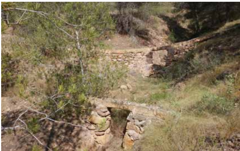
Figura 5. Pasos de agua (II y III) que salvan una pequeña torrentera. Fuente propia.
