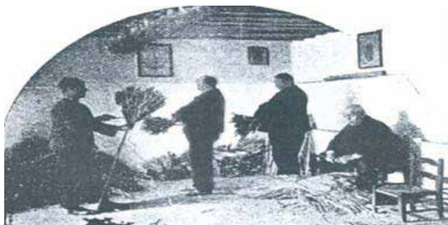
Figura 8. Elaboración de escobas y soplillos de esparto. Fuente: Ambrosio Camps Sáez.
