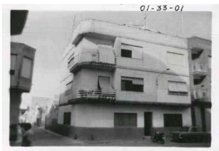
Figura 5. Vista de la calle Cruz, ahora con edificio de dos plantas, donde se instaló la familia Cerdá Garrido. A la derecha, la casa y el local en bajo donde se abrió la carbonería. Fotografía de 1984 por Fotos Rogelio. Fuente: AHMA.
