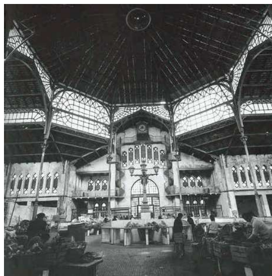
Figura 3. Imagen del interior del Mercado hacia 1968, en la que se pueden apreciar la plazoleta central y la farola original, hoy desaparecidas. Fuente: https://acortailink/YSatJM
