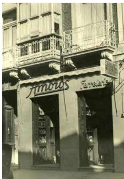
Figura 8. Vista de la fachada de la ferretería Amorós en la calle del Carmen de Cartagena. H. 1950. AGRM, FR,AFC-090-025.
