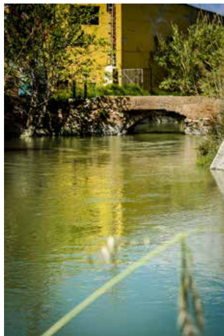
Figura 7. Puente de las Pilas. Acequia Barreras. Fuente: Archivo fotográfico de María Manzanera.
