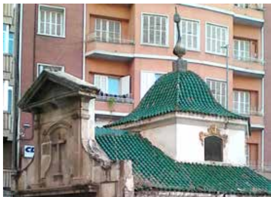
Figura 8. Detalle de las cubiertas a dos niveles con teja vidriada de color verde. Fuente: https://juanantoniocarrion.es/la-fabrica-de-la-polvora-2/
