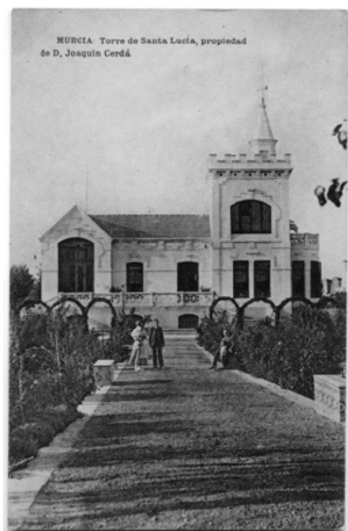
Figura 6. Torre de Santa Lucía. c. 1915. Postal Hauser y Menet Fuente: Archivo General de la Región de Murcia.
