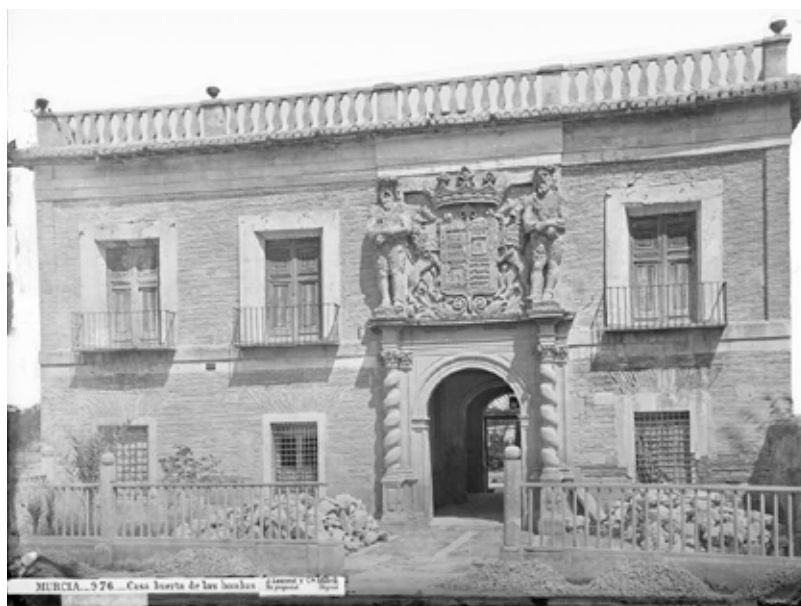
Figura 3. Casa del Huerto de las Bombas C. 1870-1871. Fotógrafo Jean Laurent. Fuente: Instituto de Patrimonio Cultural de España Ministerio de Cultura.
