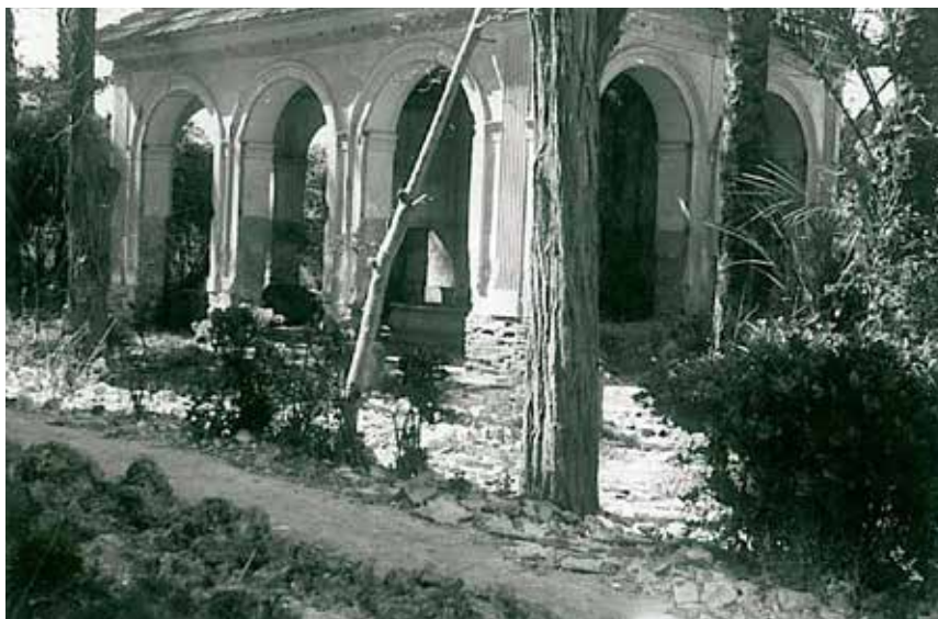
Figura 12. Torre Caradoc. Foto José Crespo. Fuente: Archivo Municipal de Murcia.
